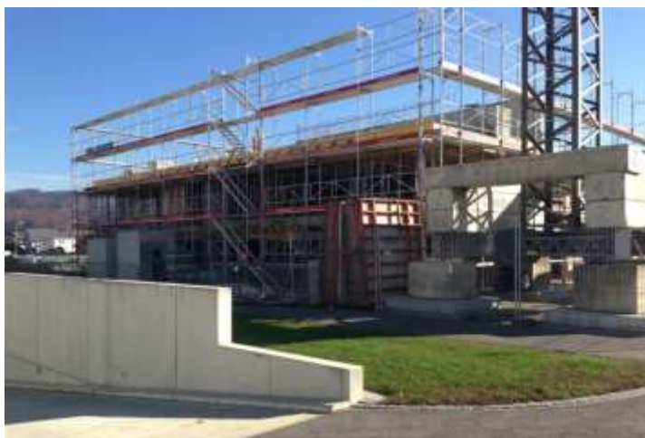
neuer Wohnblock in Rohbau
