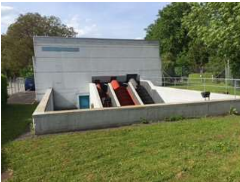
Pumpwerk mit Regenklärbecken in Gunzgen
