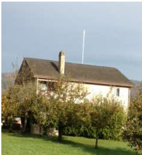
Geplante Antenne an der Mittelgäustrasse 57
