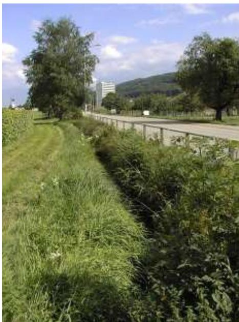
im Gebiet Kappel grosse Mengen von Bachwasser versickern. Der Kanton hat deshalb ein Ingenieurbüro beauftragt, ein Bauprojekt auszuarbeiten. Die Aufnahmen ergaben, dass die Bachsohle an mehreren Stellen ein Kontergefälle aufweist.
